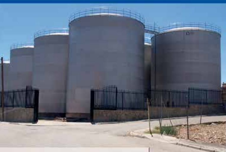
DEPÓSITOS DE ALMACENAMIENTO FABRICADOS ( IN SITU )
